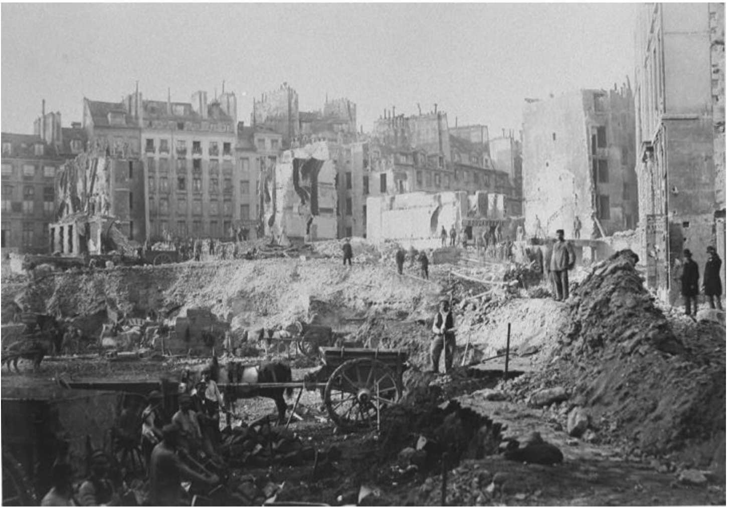
Icono 2 : Percement de l'avenue de l'Opéra et boulevard Henri IV ; Charles Marville ; 1862 - Source : BnF
