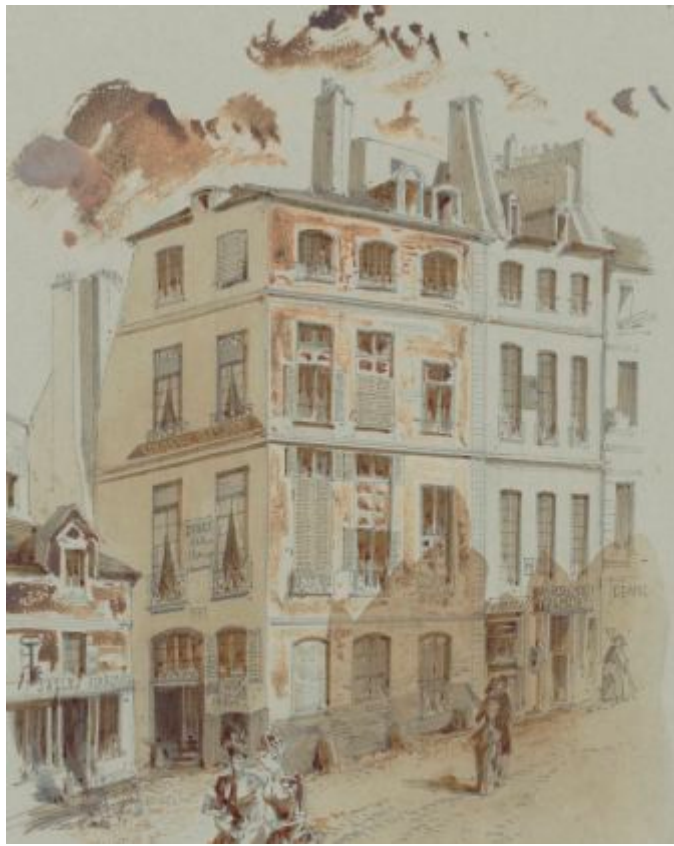
Icono 3 : La maison Prévotale au n° 17 de la rue d'Argenteuil démolie par le percement de l'Avenue de l'Opéra ; dessin ; Jules-Adolphe Chauvet ; 1881 ; Source : BnF
